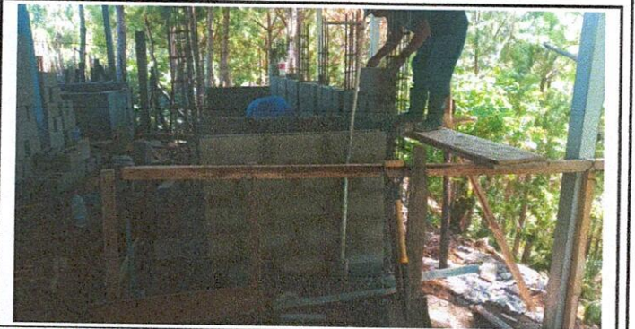
Foto 6: el estado actual del modulo de 6 bañoes esta dañado, esta inclinado y ya no esta a nivel por tal motivo es necesario la rehabilitacion de las paredes.
