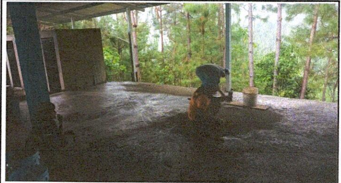
Foto 8: colocacion de plancha losa de piso en el corredor.
