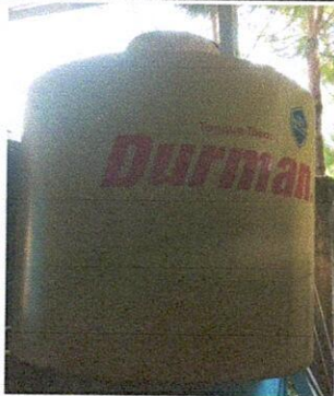
Foto 9: sustitucion del tinaco de 2,500 lts.
